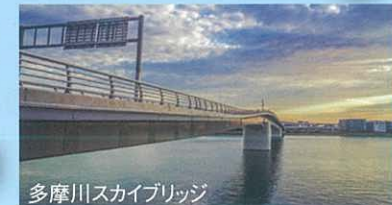
多摩川スカイブリッジ
